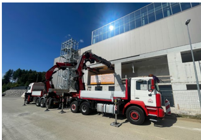
Slika 1: Pogled med montažo dizel agregata
