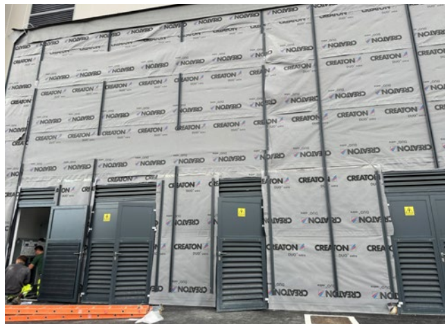
Slika 4: Zunanji pogled na TP Brinox Mira Peč
